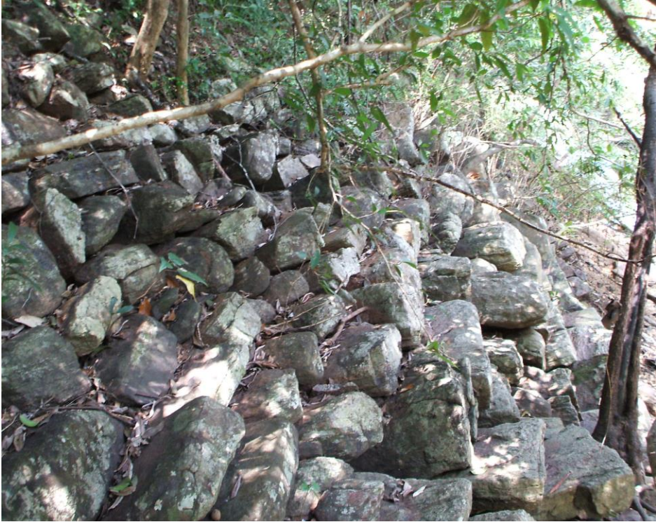
ඡායාරූපය 3. අංගම්මැඩිල්ල අමුණේ ඇල මාර්ගය ආවරණය කොට ඇති ආකාරය
